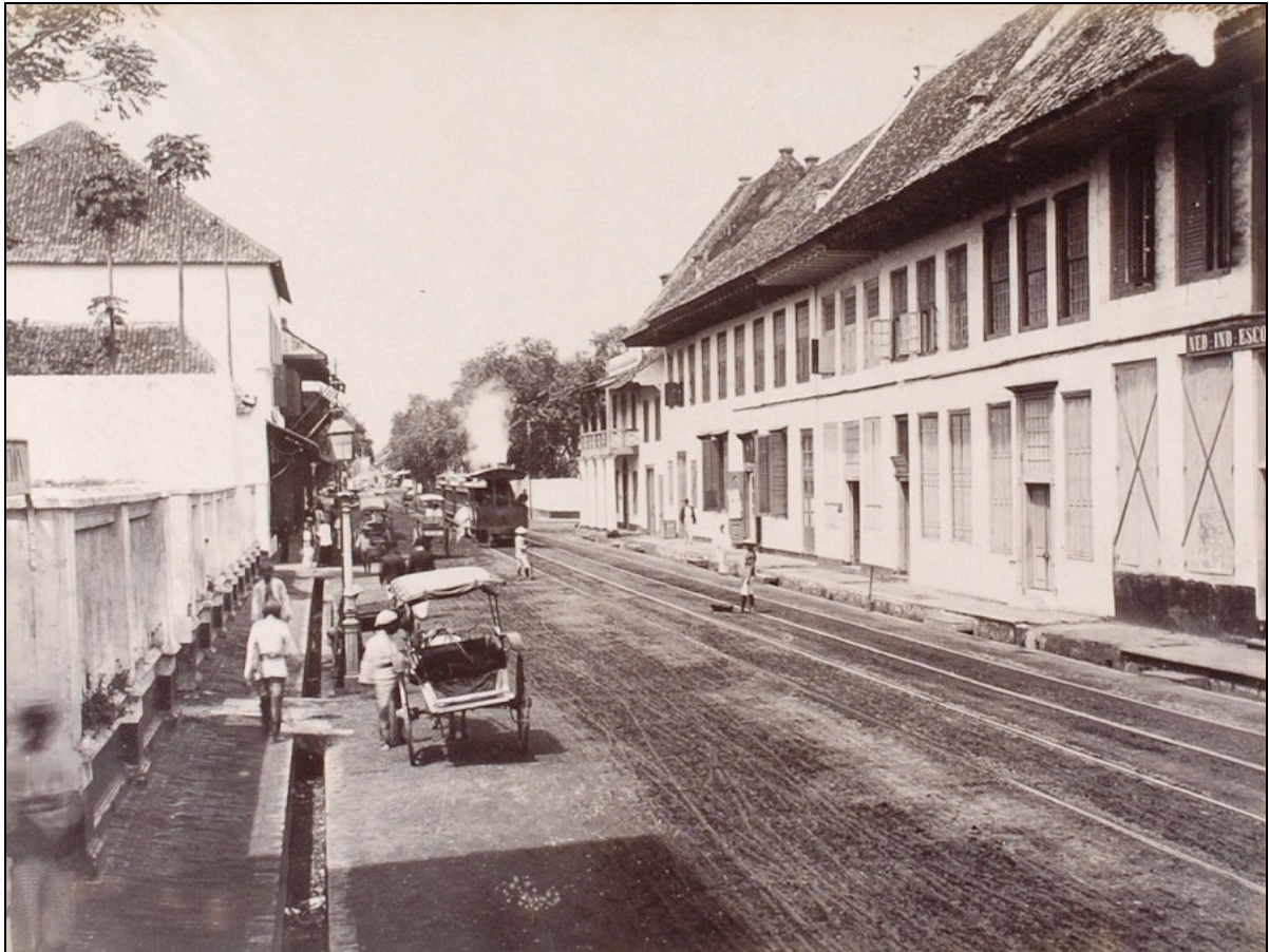
Binnen Nieuwpoortstraat te Batavia (omstreeks 1885-1905) met rechts het kantoor van de Nederlandsch-Indische Escompto Maatschappij (collectie Tropenmuseum).
